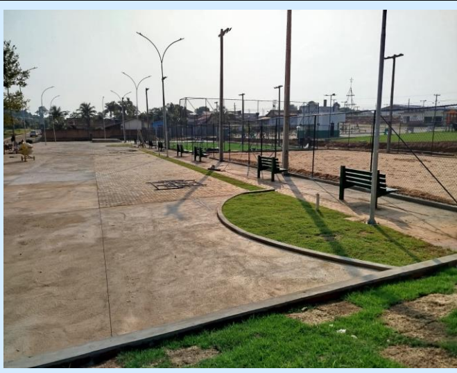
Foto 17: INSTALAÇÃO DE BANCOS, GRAMA, CALÇADAS E PAVERS
