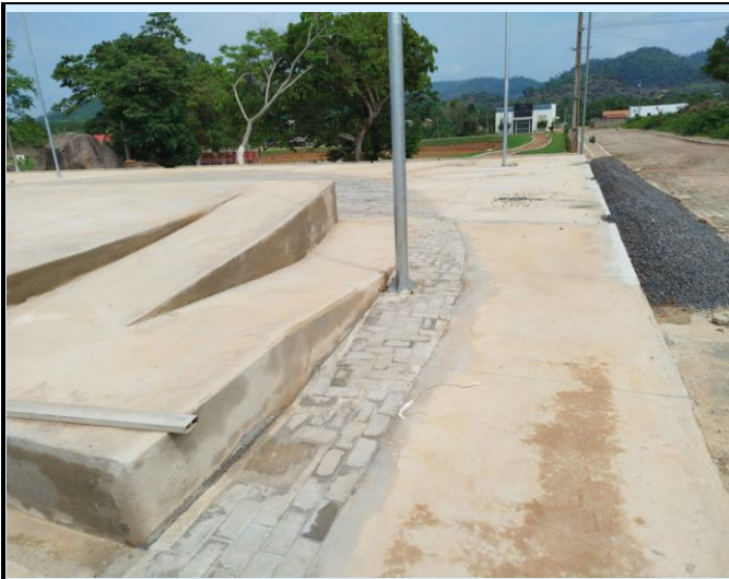
Foto 19: CONSTRUÇÃO DO PALCO
