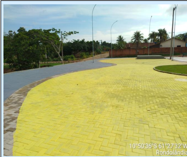
Foto 26: EXECUÇÃO DAS ILUMINAÇÕES
