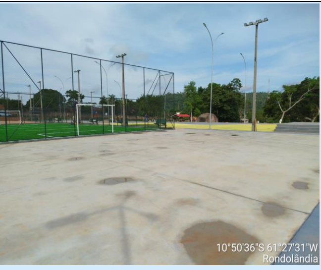
Foto 27: EXECUÇÃO DAS ILUMINAÇÕES
