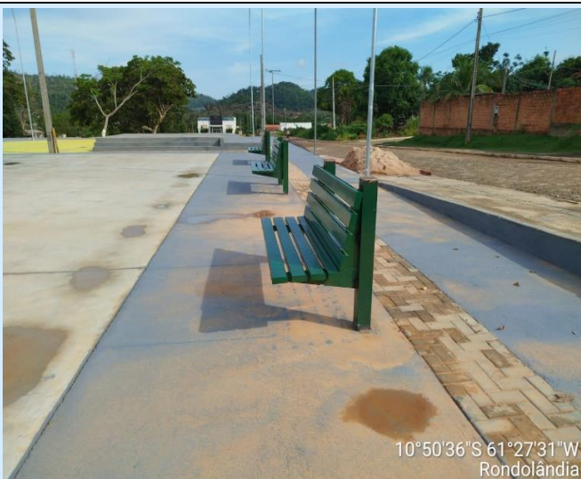
Foto 31: EXECUÇÃO DOS BANCOS
