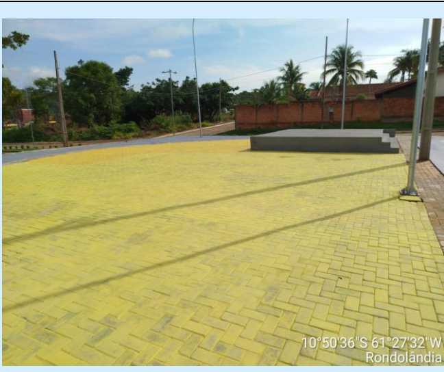
Foto 25: EXECUÇÃO DAS ILUMINAÇÕES
