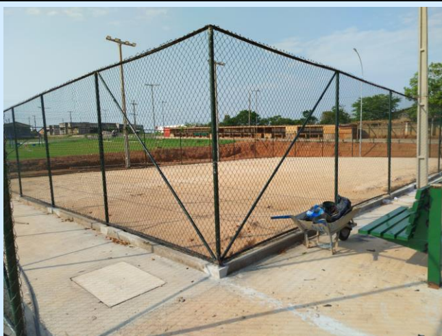
Foto 11: EXECUÇÃO DOS SERVIÇOS DA QUADRA DE AREIA COM A INSTALAÇÃO DE ALAMBRADOS REVESTIDOS
