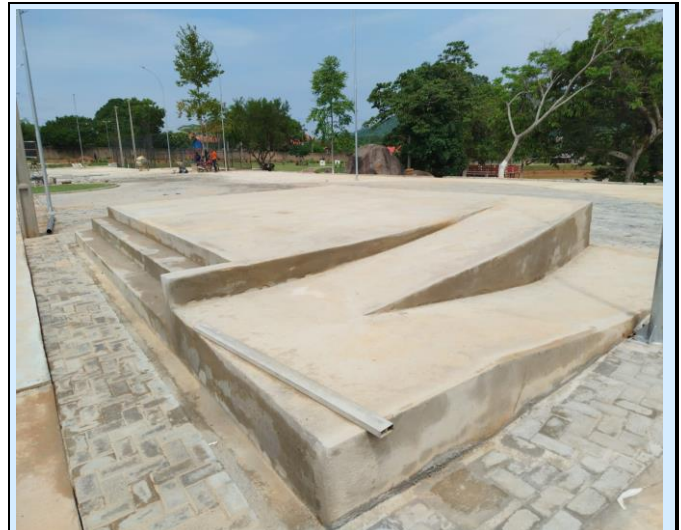
Foto 20: CONSTRUÇÃO DO PALCO
