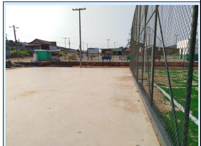
Foto 12: EXECUÇÃO DOS SERVIÇOS DA QUADRA DE BASQUETE
