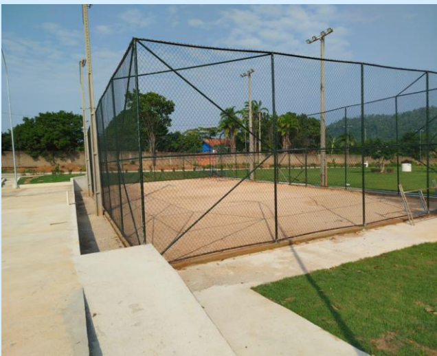
Foto 15: EXECUÇÃO DA QUADRA BEACH TENNIS
