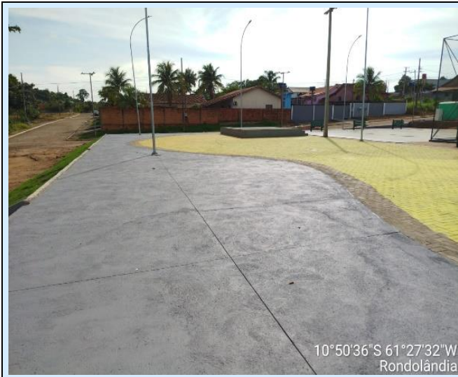
Foto 32: EXECUÇÃO DE PINTURAS
