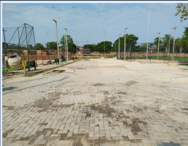
Foto 14: EXECUÇÃO DOS SERVIÇOS DA AREA DE VIVENCIA, INSTALAÇÃO DOS PAVERS
