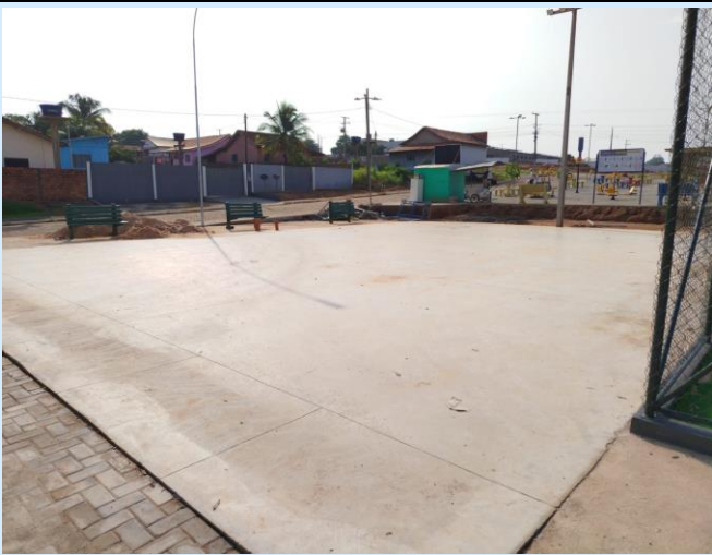
Foto 13: EXECUÇÃO DOS SERVIÇOS DA QUADRA DE BASQUETE
