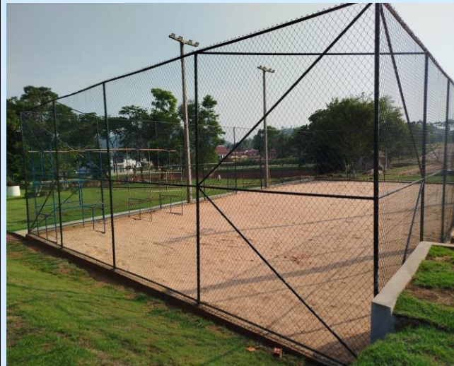
Foto 16: EXECUÇÃO DA QUADRA BEACH TENNIS
