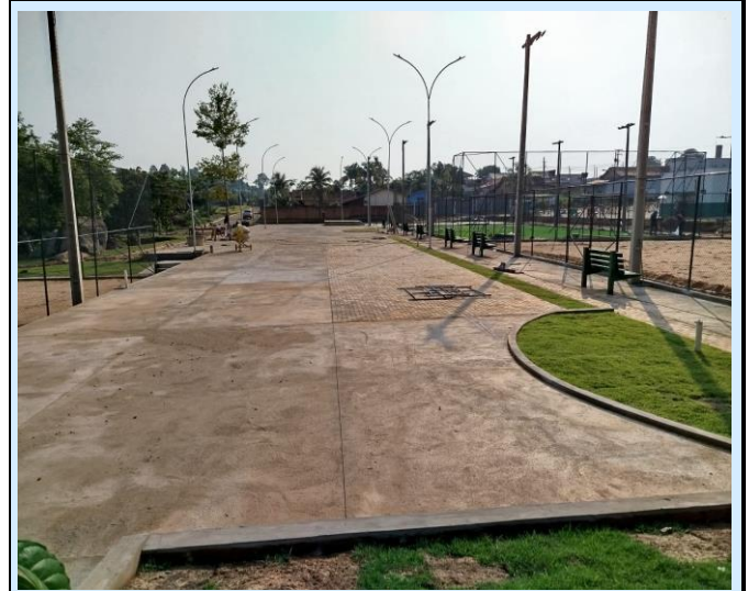
Foto 18: INSTALAÇÃO DE BANCOS, GRAMA, CALÇADAS E PAVERS
