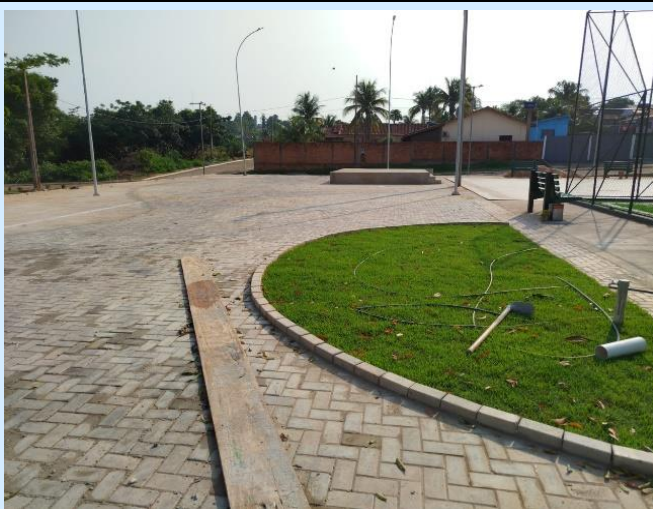
Foto 9: INSTALAÇÃO DOS PISOS PAVER NA ÁREA DE VIVÊNCIA
