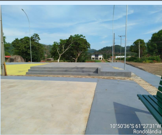
Foto 29: EXECUÇÃO DE PINTURAS
