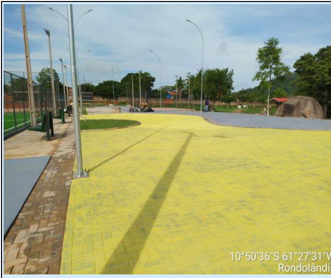
Foto 28: EXECUÇÃO DE PINTURAS
