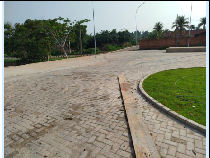
Foto 10: INSTALAÇÃO DOS PISOS PAVER NA ÁREA DE VIVÊNCIA
