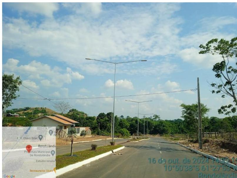
IMAGEM 16 – SERVIÇOS DE INSTALAÇÃO DE POSTE, LUMINARIAS, FIAÇÃO, ELETRODUTO, CAIXA DE PASSAGEM E ATERRAMENTO – (RUA JOSEFÁ MARIA)
