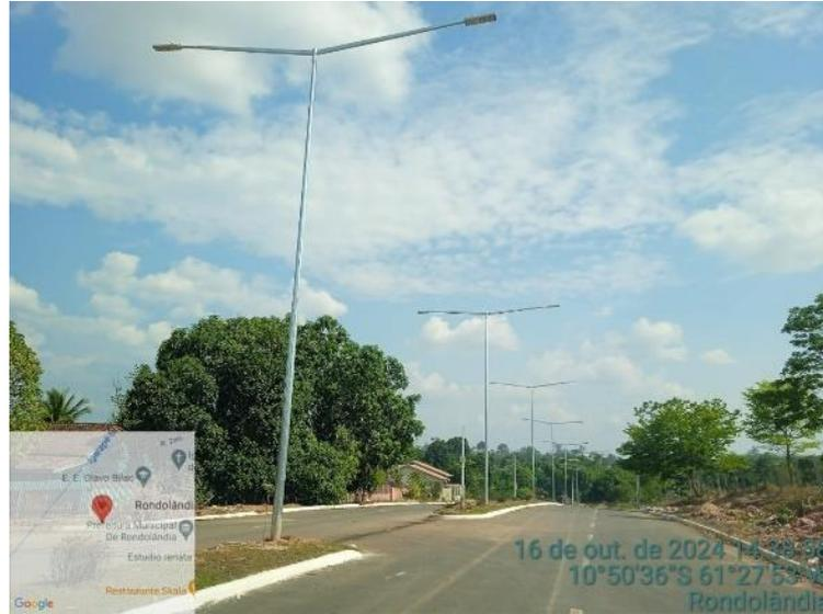
IMAGEM 19 – SERVIÇOS DE INSTALAÇÃO DE POSTE, LUMINARIAS, FIAÇÃO, ELETRODUTO, CAIXA DE PASSAGEM E ATERRAMENTO – (AV DOM BOSCO)
