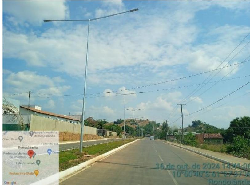
IMAGEM 09 – SERVIÇOS DE INSTALAÇÃO DE POSTE, LUMINARIAS, FIAÇÃO, ELETRODUTO, CAIXA DE PASSAGEM E ATERRAMENTO – (AV DOM BOSCO)
